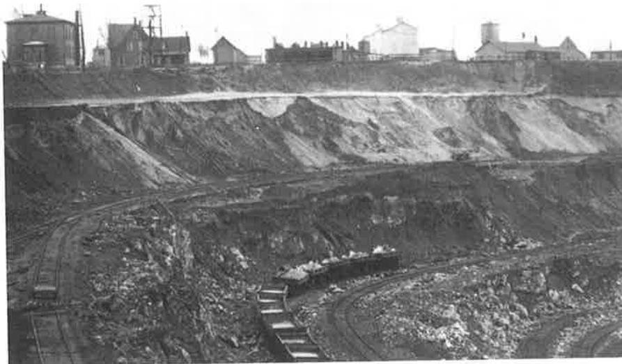
C'est dans les années 1920 que débuta l'extraction du minerai par gradins en spirale. On utilisait des locomotives à vapeur pour remonter le minerai vers les moulins. (Société d'Histoire d'Asbestos)
