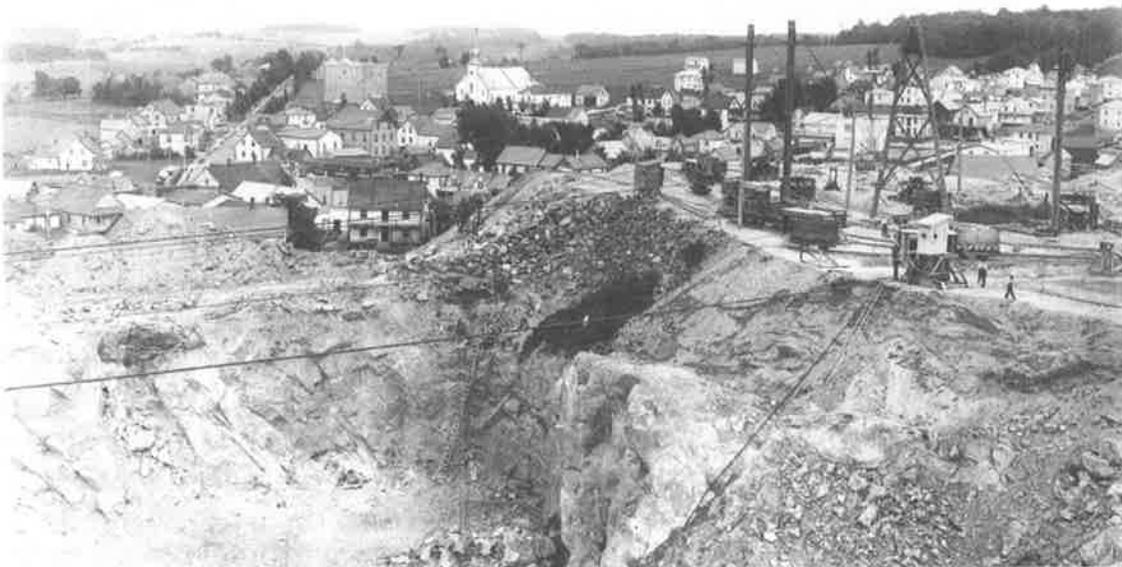
Vue du système de transport du minerai d'amiante. Celui-ci hissé à la surface à l'aide de câbles et de boîtes, était déversé dans des wagons pour ensuite être conduit au centre de transformation. (Société d'Histoire d'Asbestos)
