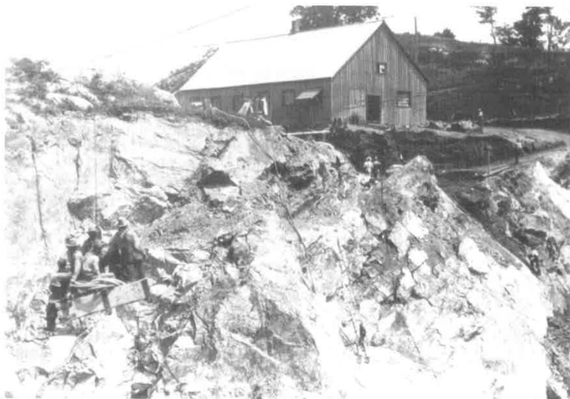
Ouvriers dans un *carriage box* qui se dirige vers le hangar où l'on broyait l'amiante au moyen de marteaux avant de le mettre en poche. (Société d'Histoire d'Asbestos)
